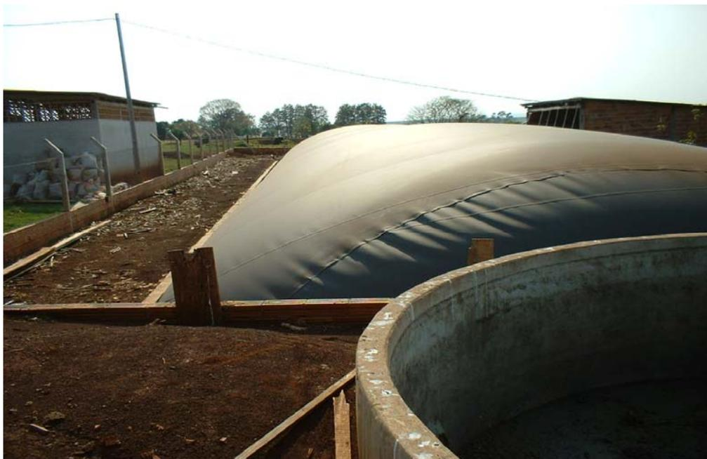
Figura 2. Biodigestor tubular com capacidade de 800 m<sup>3</sup> de biomassa. Granja Stein, município de Entre Rios do Oeste, Estado do Paraná.
