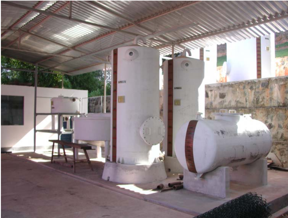
Foto 03 Vista parcial da Planta Piloto de Biodiesel
