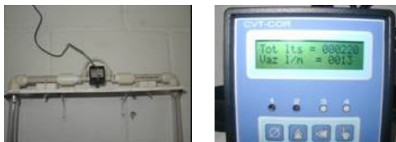
Figuras 11 e 12 – Snsor-totalizador de Vazão Instalado no Abrigo (COELHO et al, 2005).
