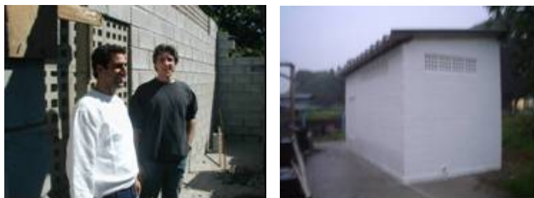
Figuras 9 e 10 – Construção em Alvenaria para Abrigo dos Equipamentos (COELHO et al, 2005).
